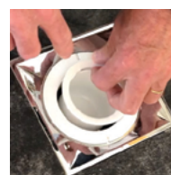
Modification sans travaux lourds
